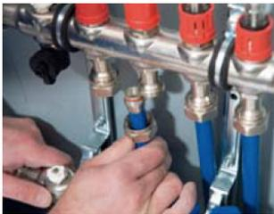
Mettre en place le raccord (écrou, bague, partie supérieur). Posez le tuyau dans les rainures pour le plancher et recommencer l'opération de retour au collecteur.
