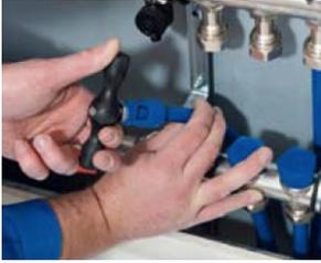
Commencer par raccorder le tuyau qui est le plus haut en passant derrière le collecteur du bas.
